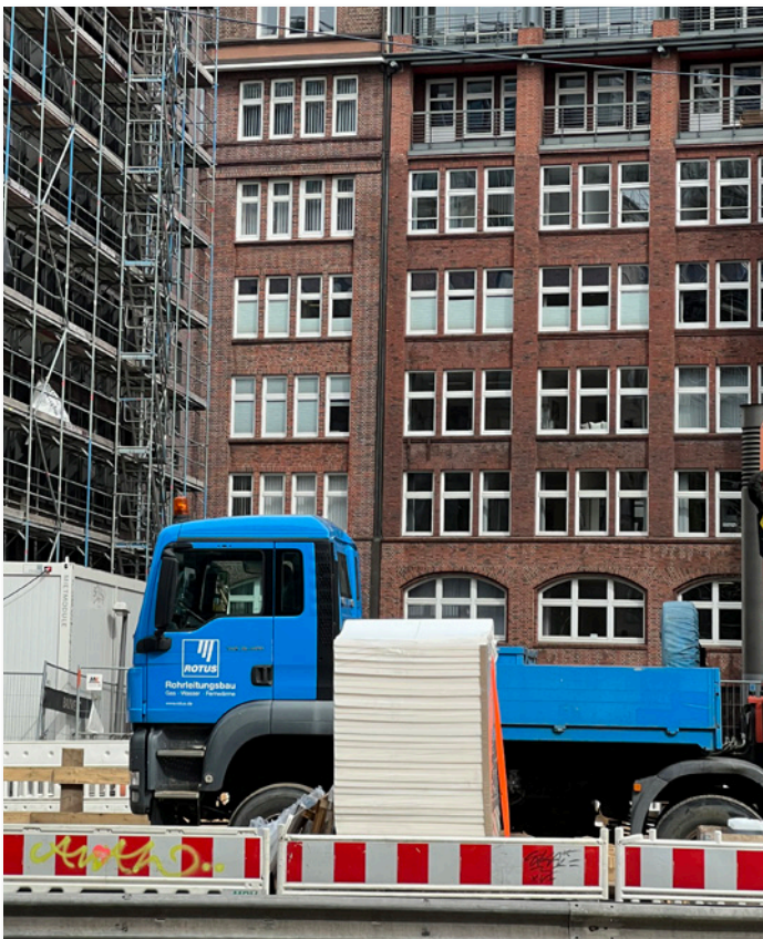
ROTUS aus Kassel bei Tiefbauarbeiten in Hamburg
